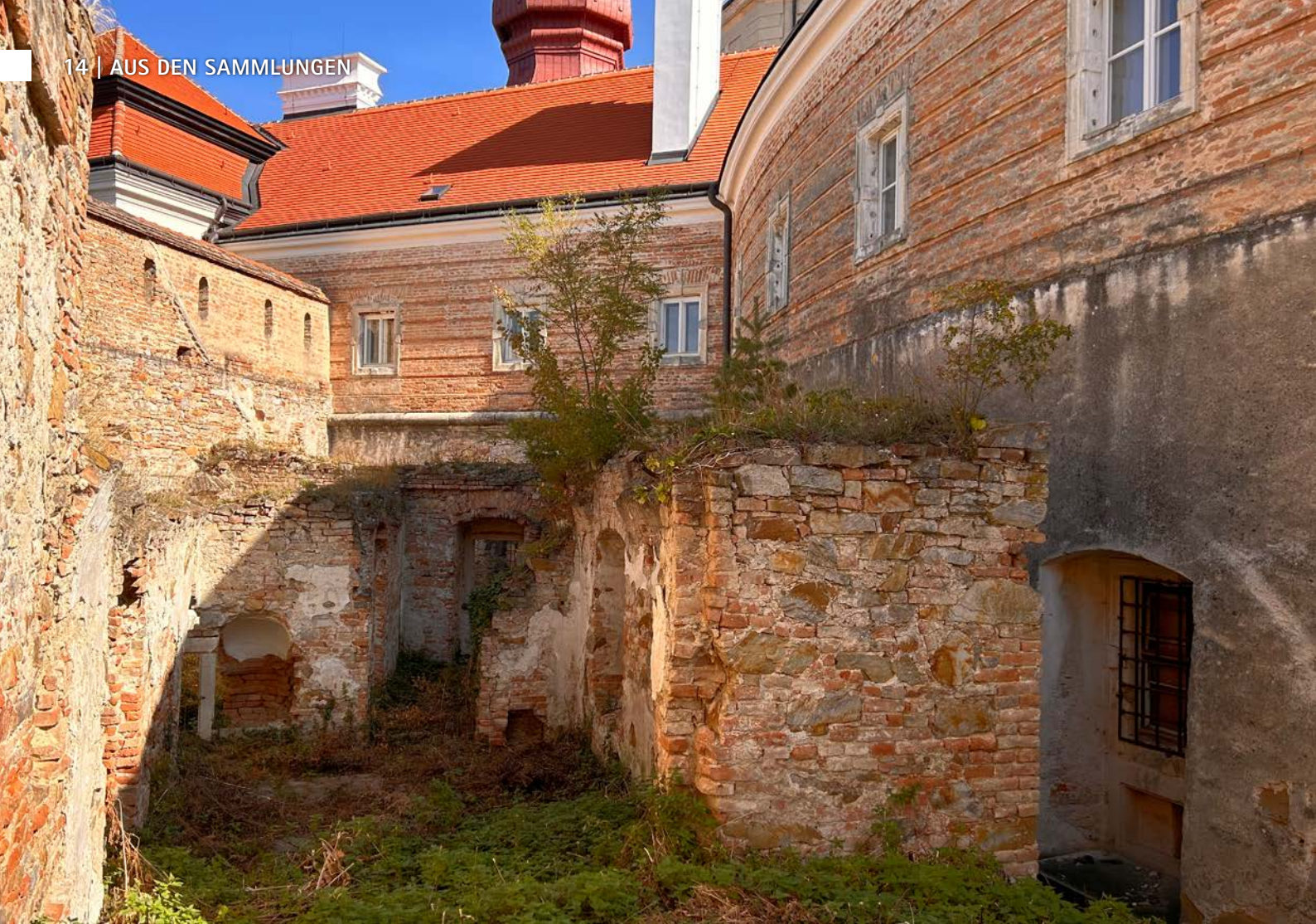
Das ehemalige Göttweiger Schlachthaus ist heute Ruine und befindet sich im Westen des Stiftes vor den heutigen Gästezimmern.
