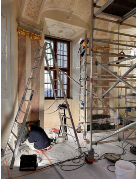
Restaurierungsarbeiten in der ehemaligen Sebastiani-Kapelle
