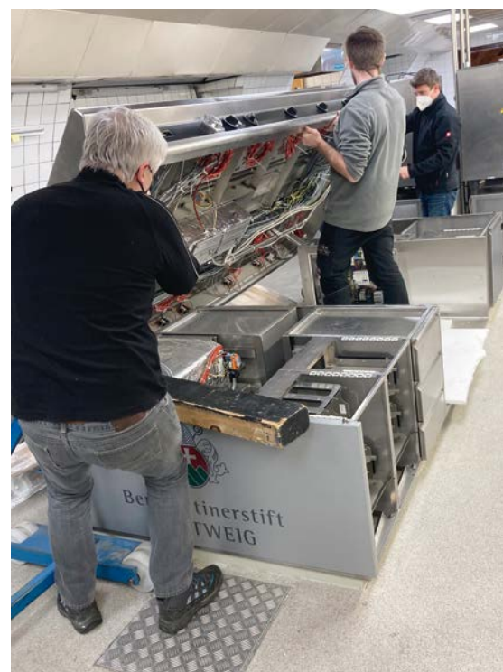
Der neue Herd wird installiert
